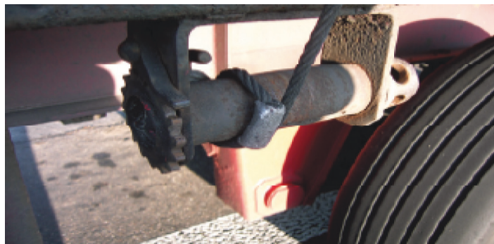
Figura 24: Cable de acero tensado con torno
